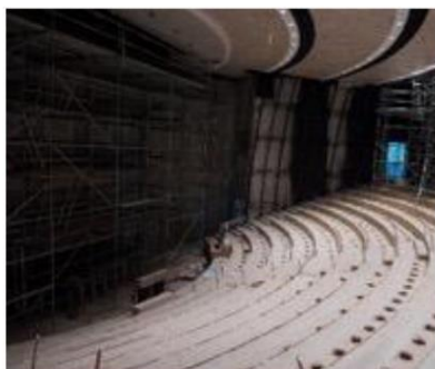
Auditórium az építési fázisban és
